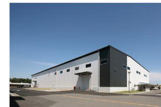
2022年 滋賀工場 塗装棟稼働
