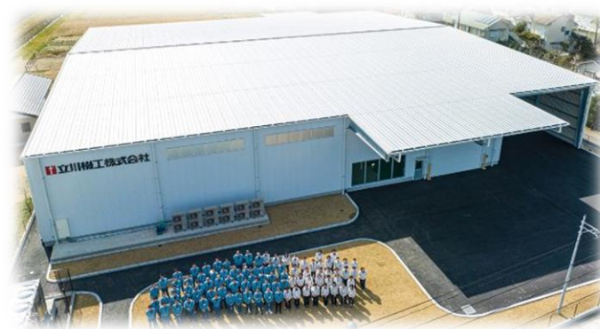
樹脂部品 新成形棟竣工
