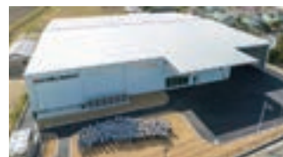
立川機工(株)新成形棟(2023年4月稼働開始)
