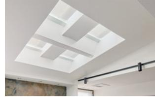
水平面から40°までの傾斜した窓に対応するヨコ型ブラインド。
