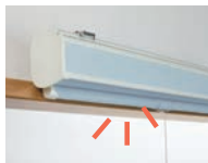
窓枠にあたって上がりきらない。
